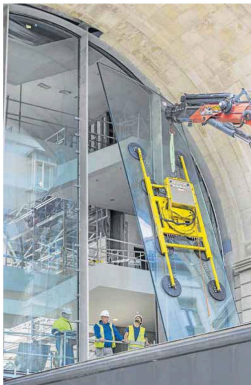
Detalle de la instalación en la arcada que da a la calle Sanz de Sautuola.
