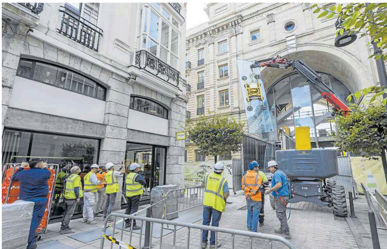
Imagen de la espectacular operación de colocación de las piezas que cubren el arco del emblemático inmueble de Faro Santander. FOTOGRAFÍAS: ROBERTO RUIZ
