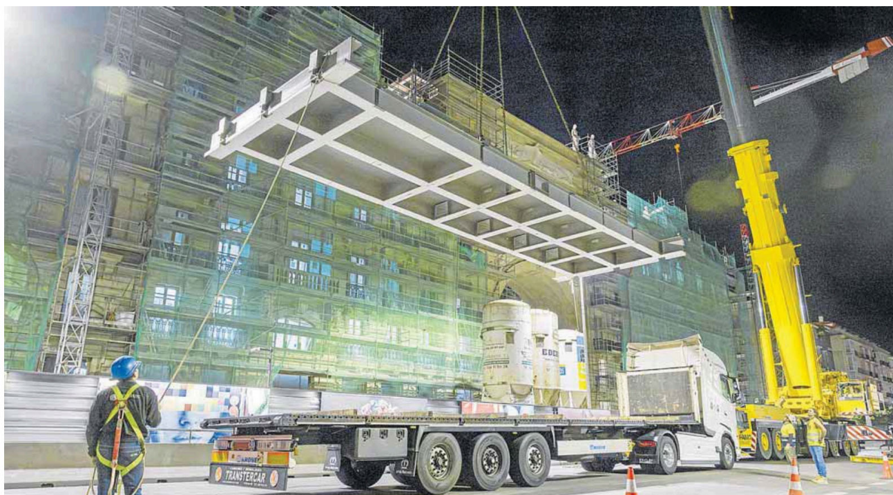
Las labores de izado de las diversas piezas, destinadas a la sexta planta, se prolongaron desde cerca de la medianoche hasta bien entrada la madrugada. FOTOGRAFÍA: ROBERTO RUIZ
