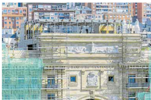
La estructura ubicada en la futura terraza del inmueble.
